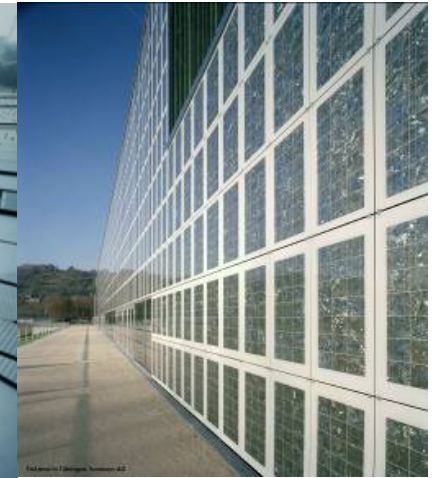
Photovoltaikmodule aus kristallinem Silizium als Gebäudeaußenhülle
